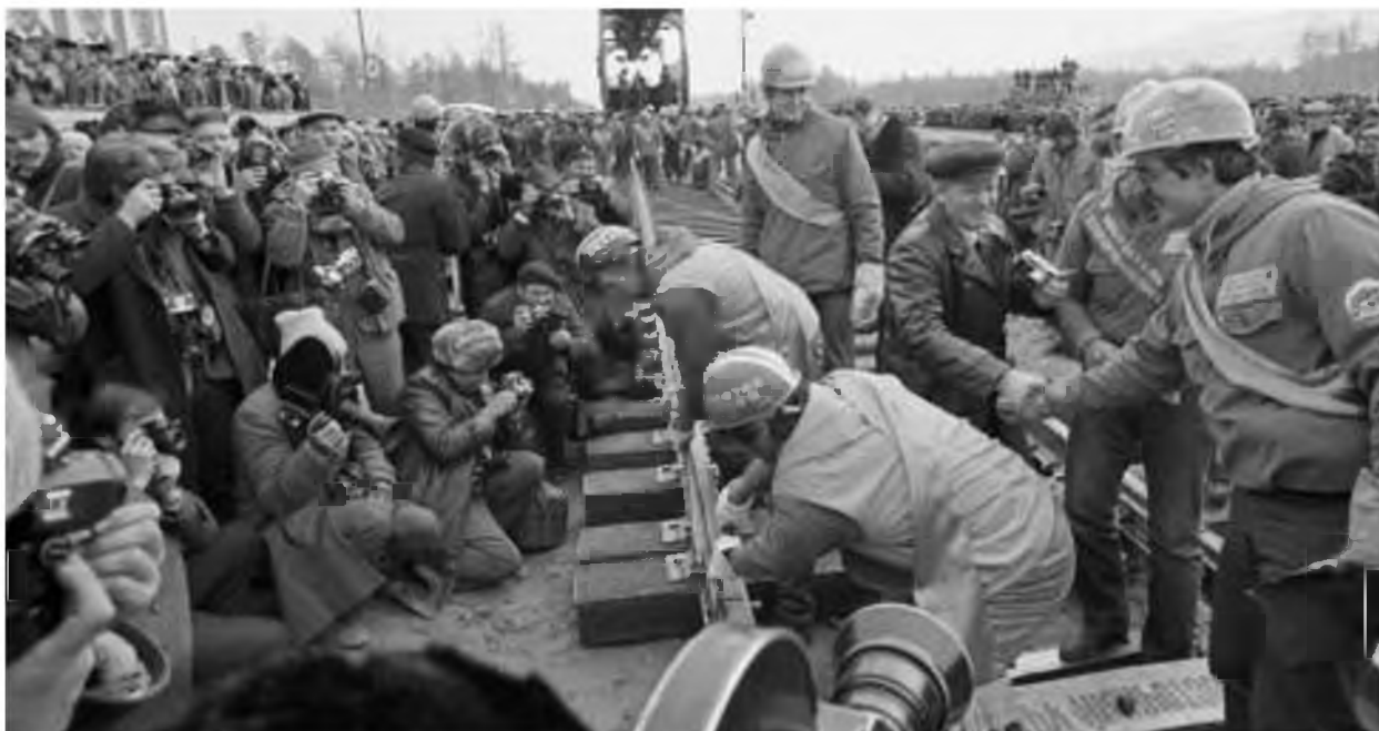
бригада Ивана Варшавского. Укладка «золотого звена»
